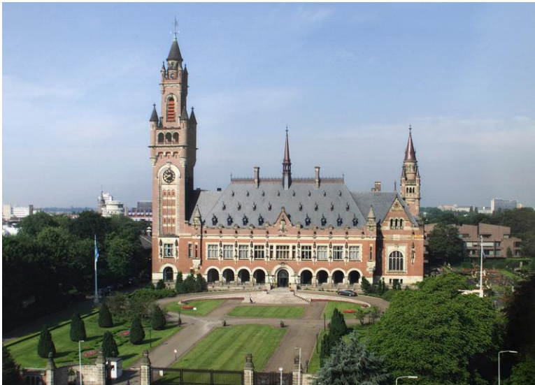
Будівля Міжнародного суду, Гаага (Нідерланди)
