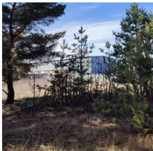
Через рік після пожежі 01.03.2024
