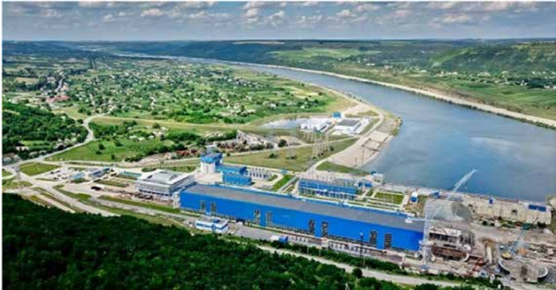
Рис. 4. Вигляд на буферну водойму Дністровської ГАЕС (ПрАТ..., 2023)
