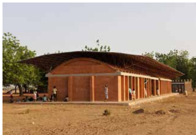
Рис. 2. Будівля середньої школи в м. Гандо, Буркіна-Фасо, 2001 р. (архітектор Френсіс Кере) (Diébédo Francis Kéré)
